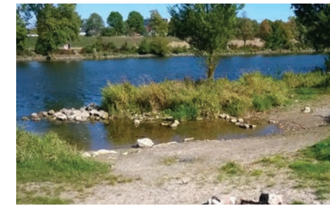
Umgesetzte Maßnahme am Unteren Wöhrd in Regensburg
