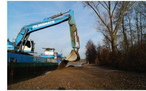
Kiesvorschüttung oberhalb von Bad Abbach (R)
