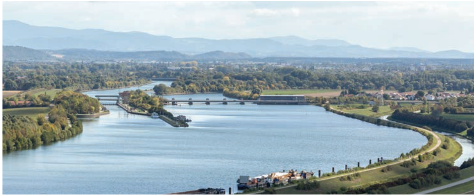
Blick auf die Donau mit der Staustufe Straubing und Wasserkraftanlage (WSA)
