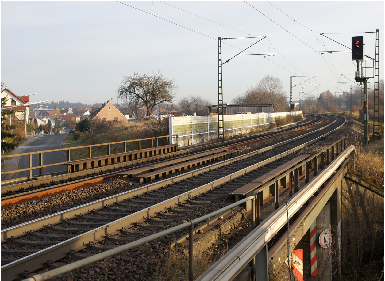
Sicht auf Batzhausen mit vorhandener Lärmschutzwand – Standort der Aufnahme war der örtliche Bahnhof
