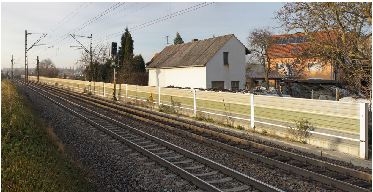
Lärmschutzwand Batzhausen bei Bahnkilometer 46,8 Quelle: Regierung der Oberpfalz, Fotos vom 14.11.2011
