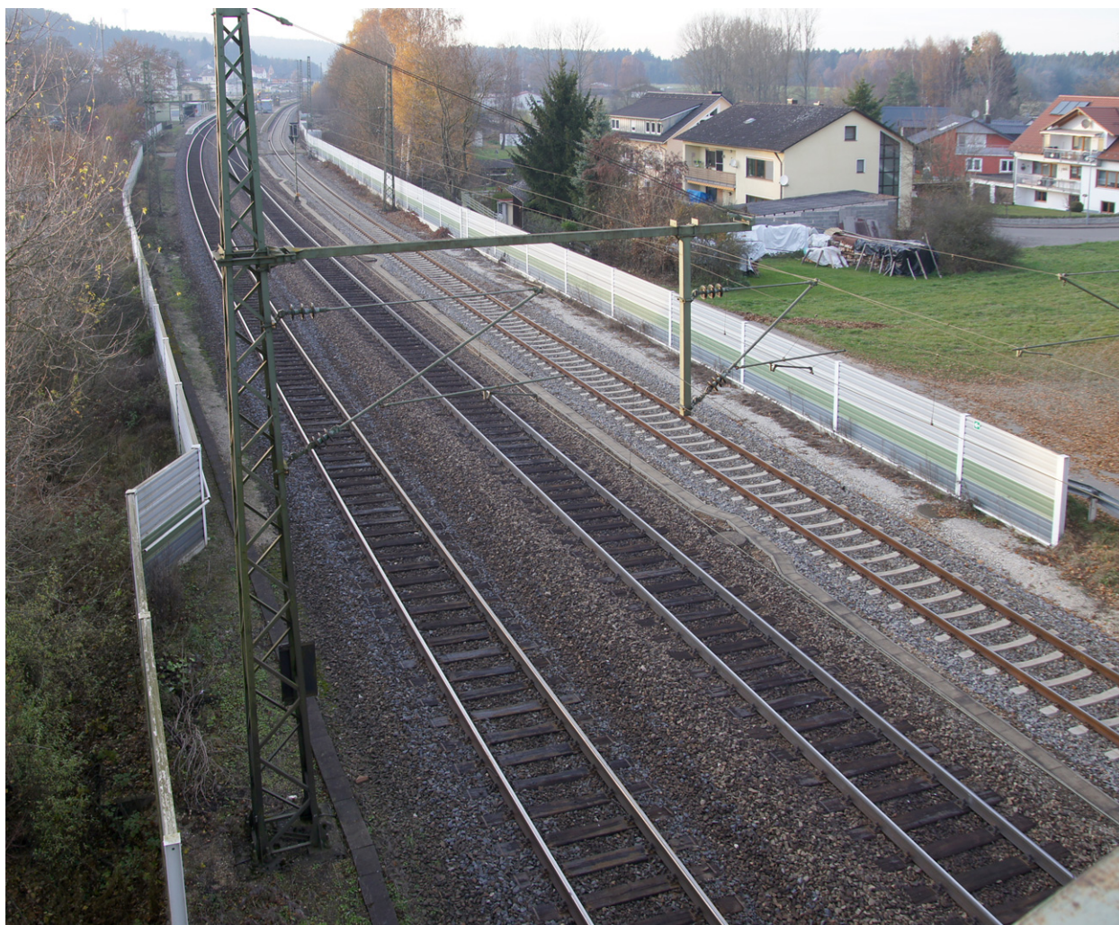
Ansicht von einer Bahnüberführung Richtung Bahnhof Seubersdorf i.d.OPf.
