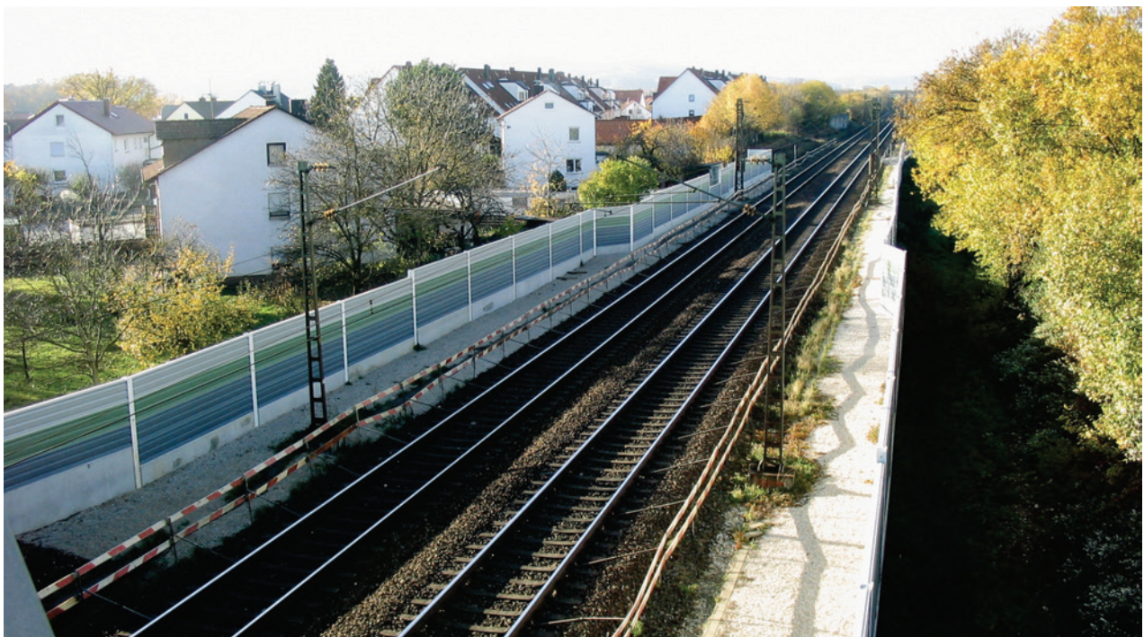
2 m hohe Lärmschutzwände in Woffenbach in nordwestlicher Richtung
