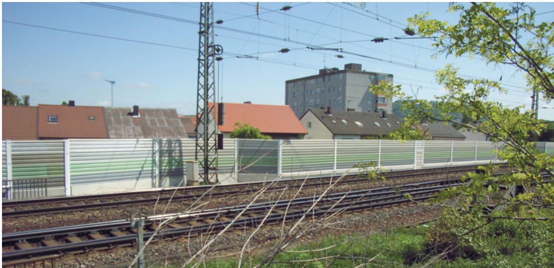
2 m hohe Lärmschutzwand im Bereich Löwenstraße in Neumarkt i.d.OPf., in der Nähe des Bahnhofs.
