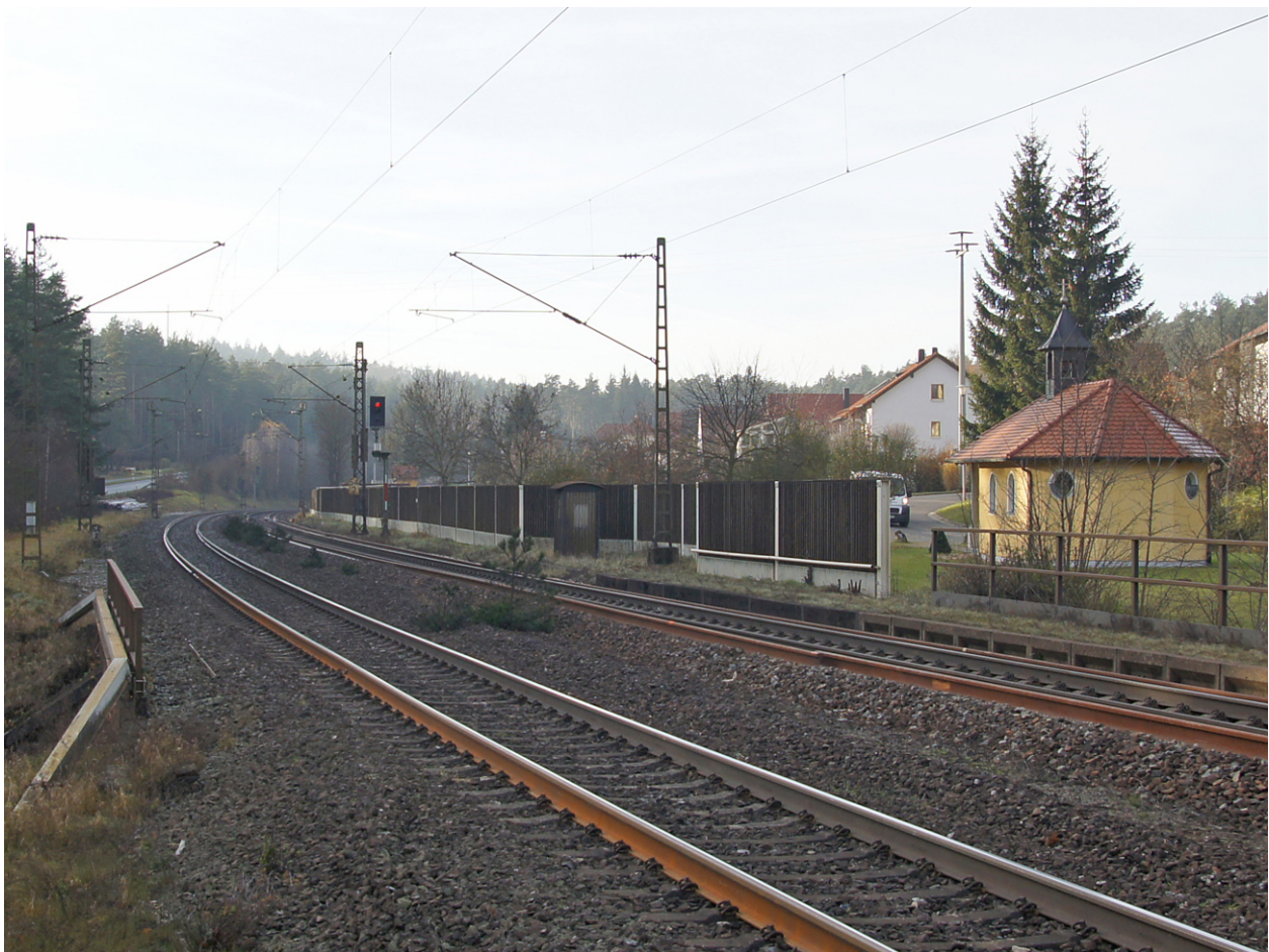
Die Bahnlinie Regensburg-Nürnberg bei Deining-Bahnhof aus östlicher Richtung
