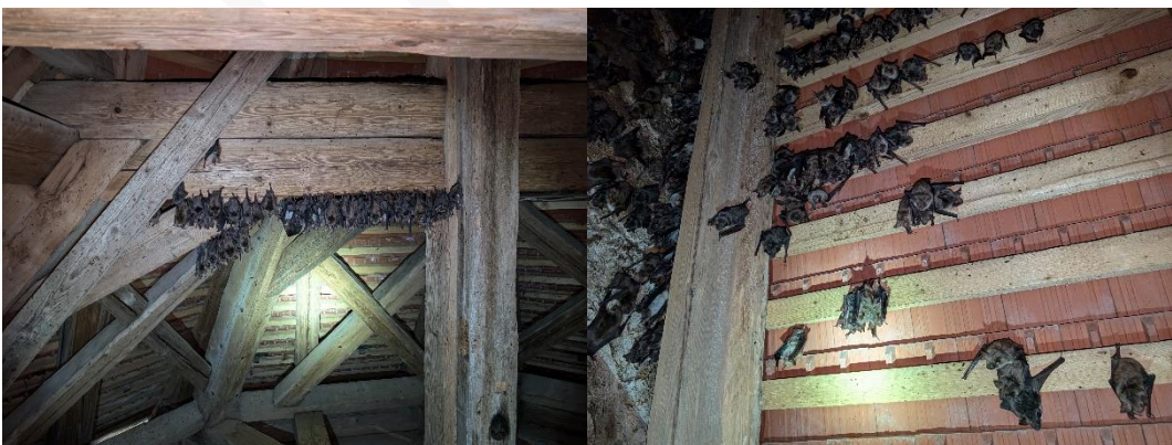
Abb. 12: Hangplätze Balken und Dachlatten (Foto: Mayer)
