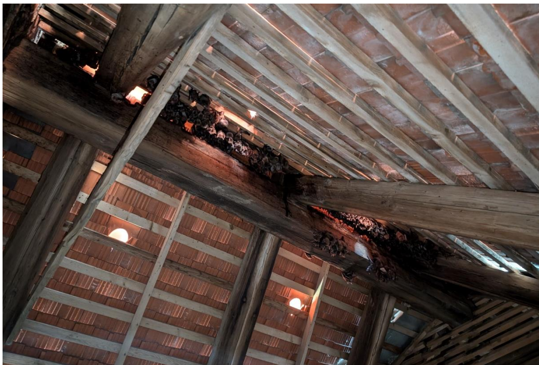
Abb. 5: Hangplätze im Firstbereich (Foto: Mayer)
