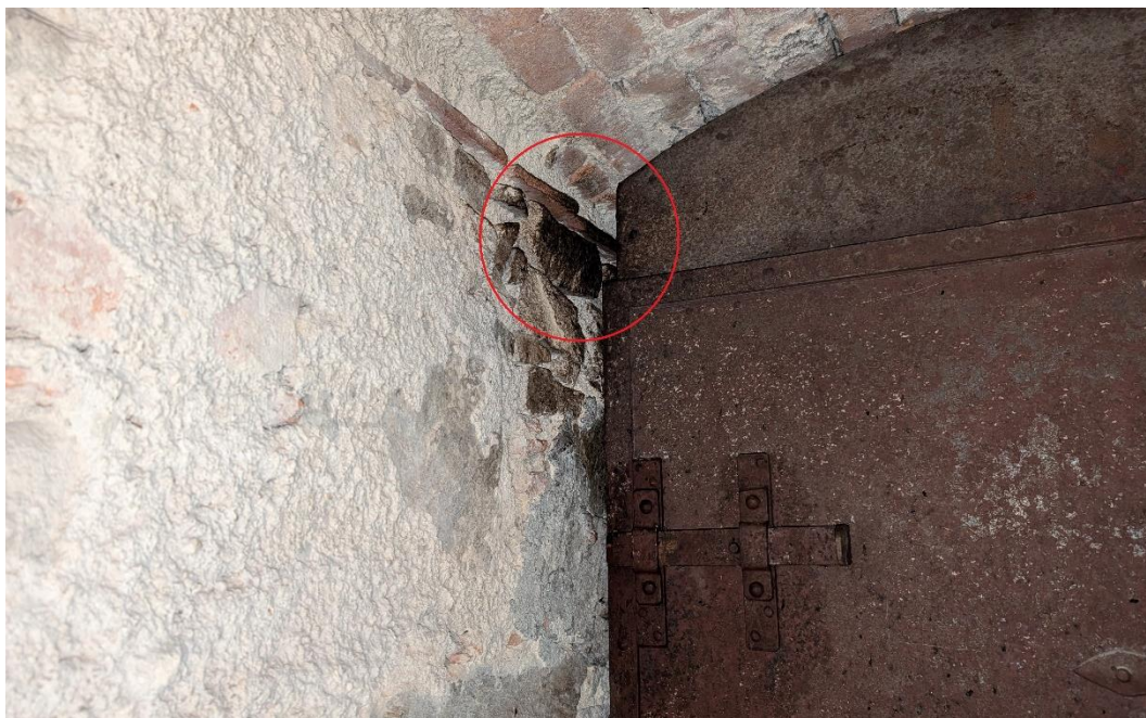
Abb. 7: Durchschlupföffnung zum Langhaus (Foto: Mayer)
