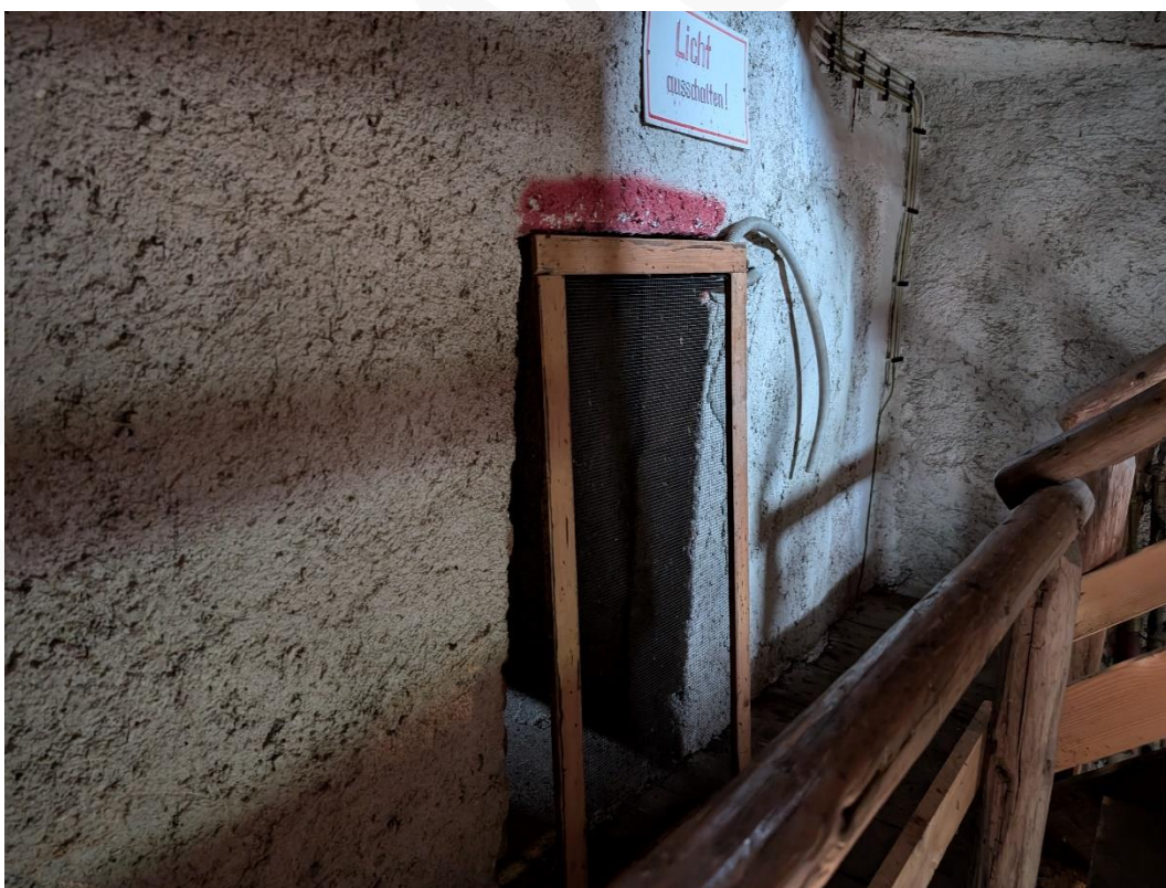
Abb. 24: Durchflugsöffnung vom Langhaus in den Turm (Foto: Mayer)
