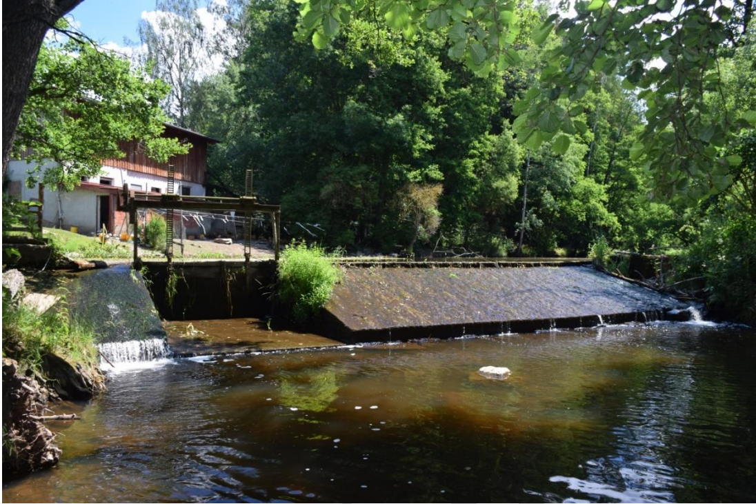
Abb. 14: Wehr an der Finstermühle ohne Fischwanderhilfe (Foto: Harrandt)
