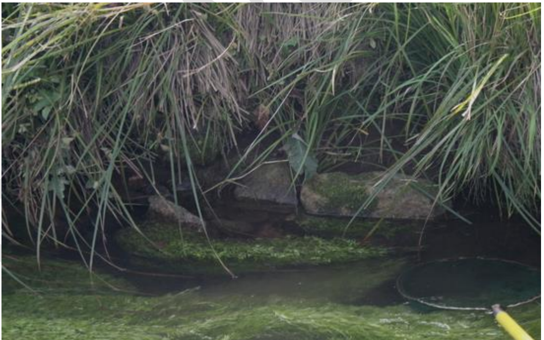
Abb. 8: Ufer- und Sohlenbefestigung am Loisbach (Foto: Ring, 13.09.2011)
