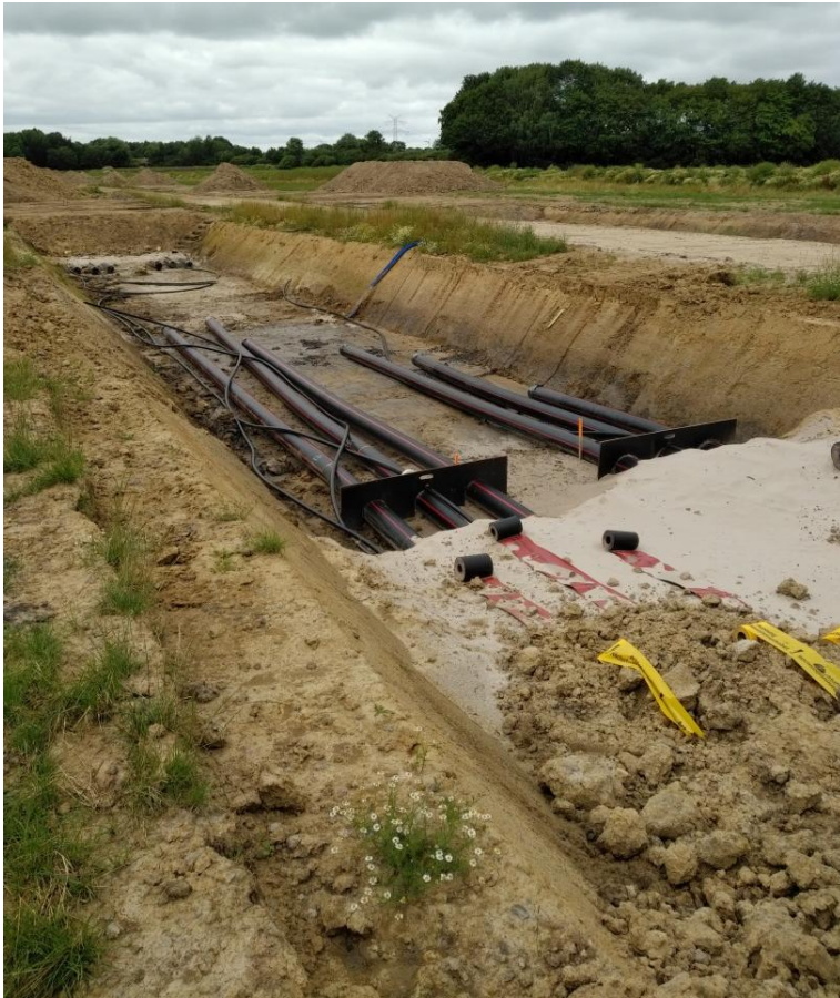
Abbildung 11: Kabelgraben mit 2 Kabelsystemen = 1 Stromkreis
