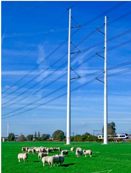
Abbildung 17: TenneT Wintrack-Mast (Niederlande)
