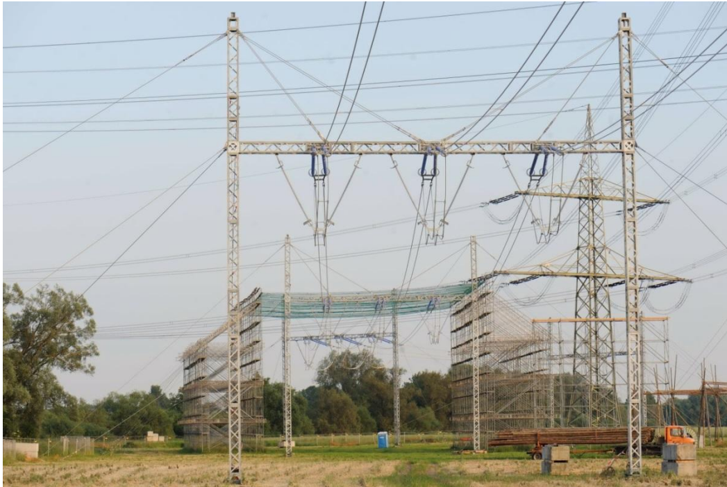
Abbildung 7: Einsatz von Provisorien: 380-kV-Freileitungsprovisorium für ein System, mit errichtetem Schutzgerüst (Hintergrund)
