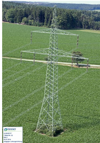
Abbildung 18: 380-kV-Stahlgitter-Mast Nr. 23 der 380-kV-Ltg. Isar – Pleinting (B117)
