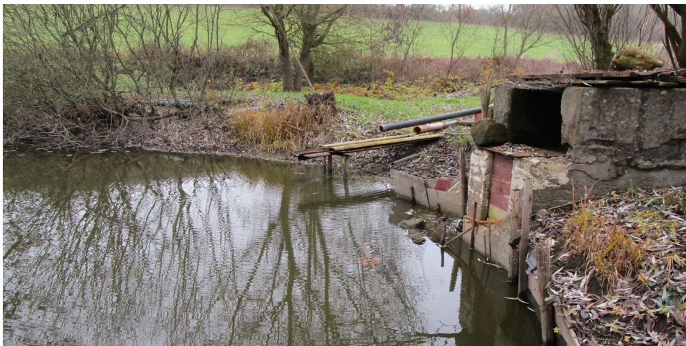
bestehendes Auslaufbauwerk (Aufnahme Herbst 2019)
