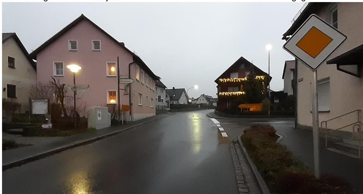
Bild 16: Übereckverbindung der St 2120 in der Ortsdurchfahrt; kein Platz für Linksabbiegestreifen
