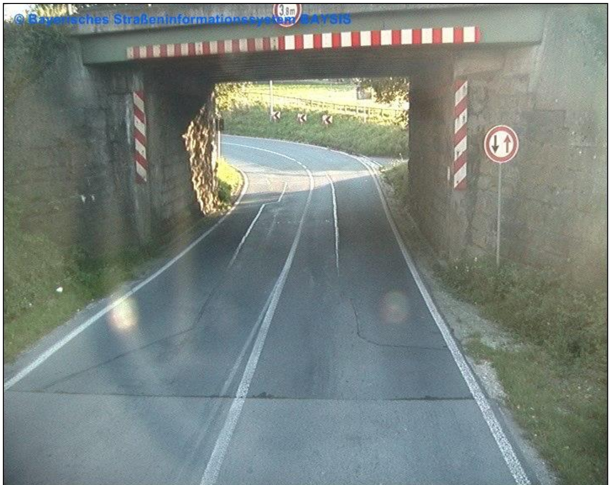
Bild: Bestehende Straßenunterführung im Zuge der Bahnlinie - Blick stadteinwärts
