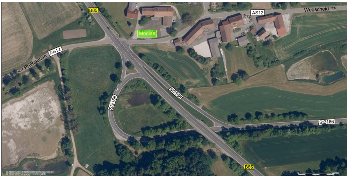
Abbildung 1: Kreuzungsbereich B85 - AS12 bei Mönlas mit zwei Anschlussrampen der St2166 weiter südwestlich (in Trompetenform) und der einspurigen Beschleunigungsrampe von der St2166 zur B85 aus Richtung Südosten
