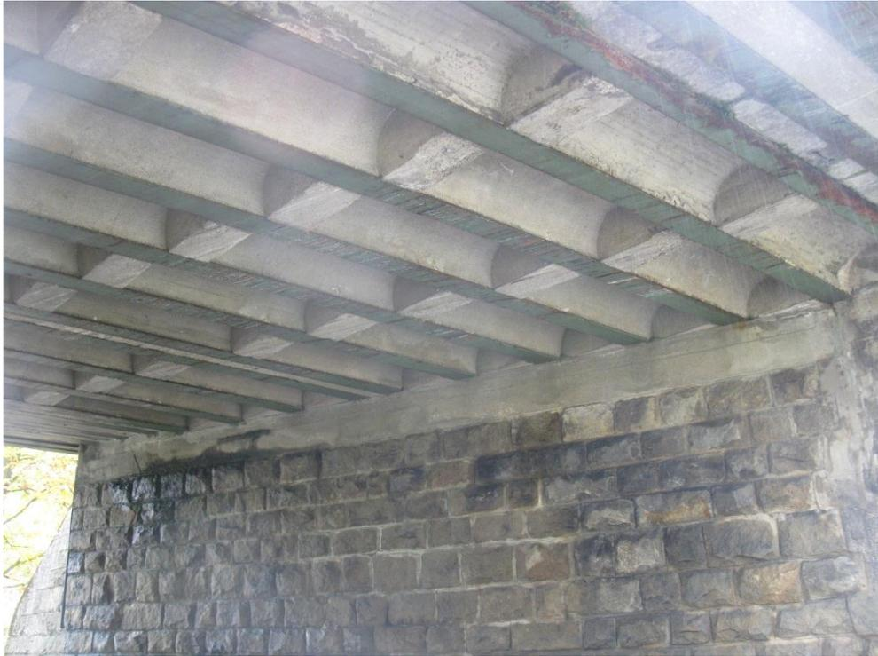
Abbildung 4: Unteransicht des Überbaus der Bahnbrücke
