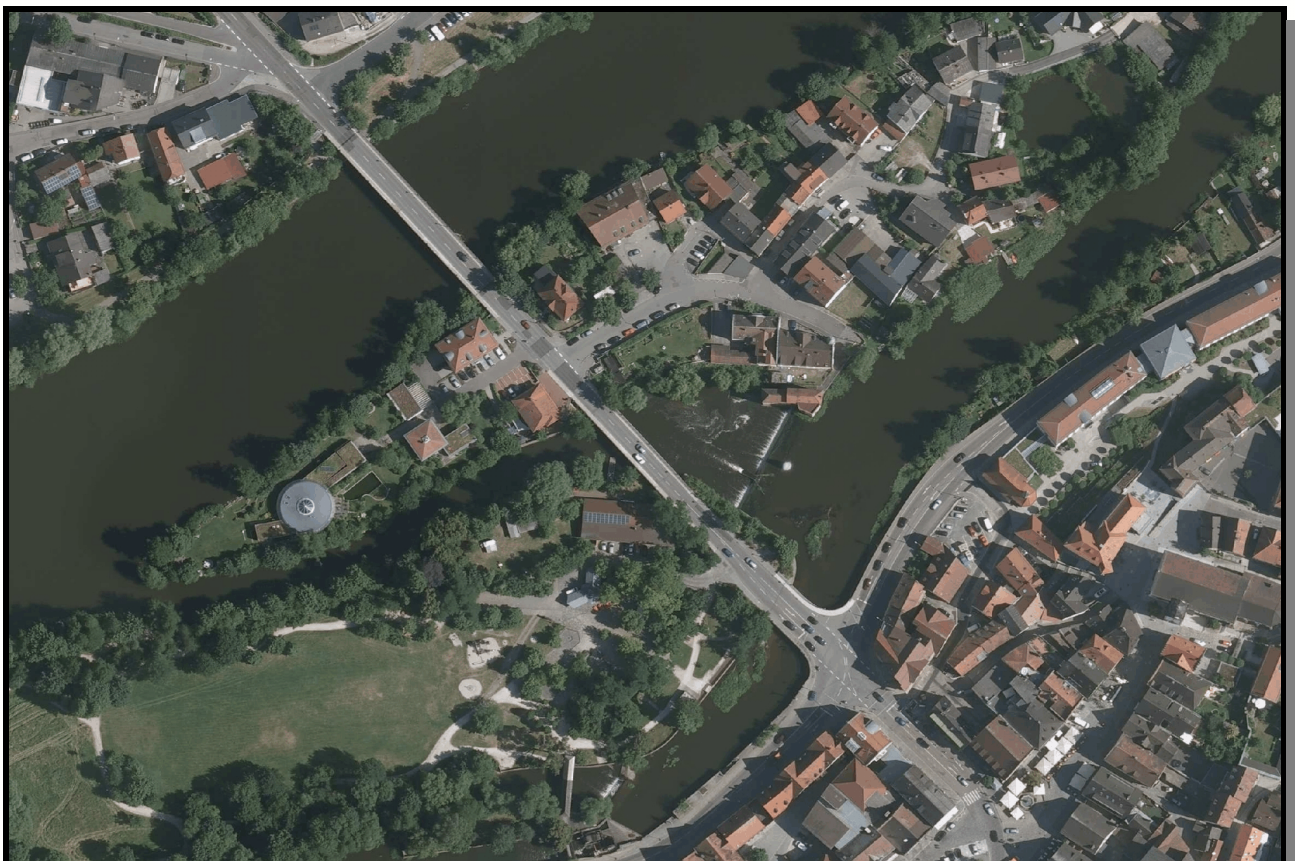
Luftbild der Naabbrücken im IST-Zustand
