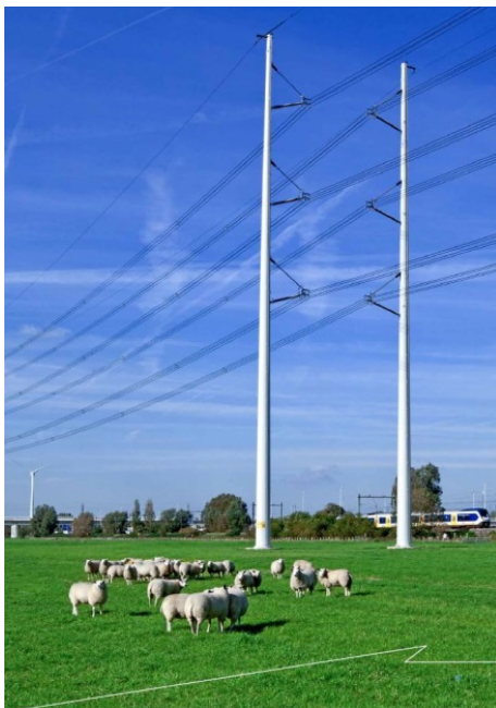
Abbildung 4: Wintrack-Pylon (Doppelpylon)
