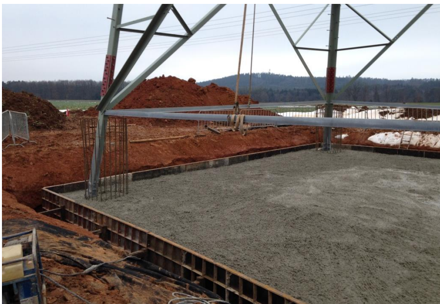
Abbildung 19: Plattenfundament
