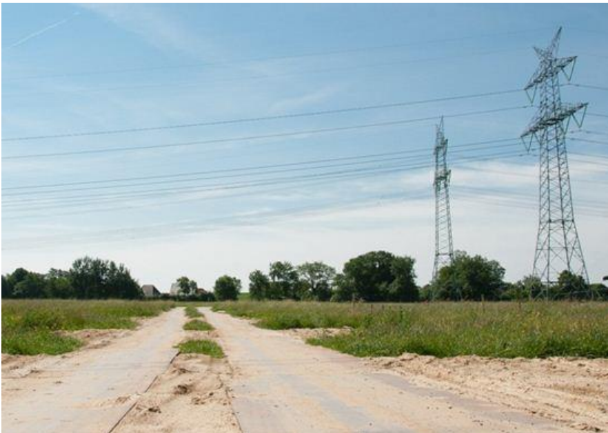
Abbildung 16: Beispiel für eine temporäre Mastzufahrt
