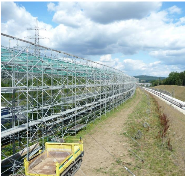
Abbildung 22: Schutzgerüst aus Metall und Schleifgerüst aus Holz
