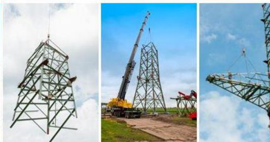
Abbildung 20: Mastmontage mittels Mobilkran
