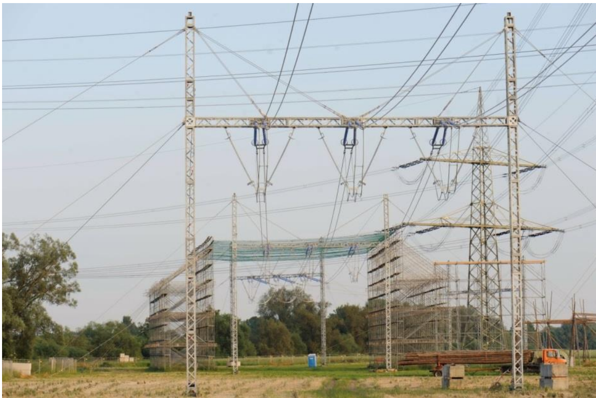
Abbildung 14: 380-kV-Freileitungsprovisorium für ein System mit errichtetem Schutzgerüst
