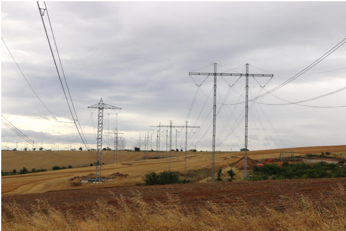
Abbildung 12: 380-kV-Freileitungsprovisorium für zwei 380-kV-Stromkreise
