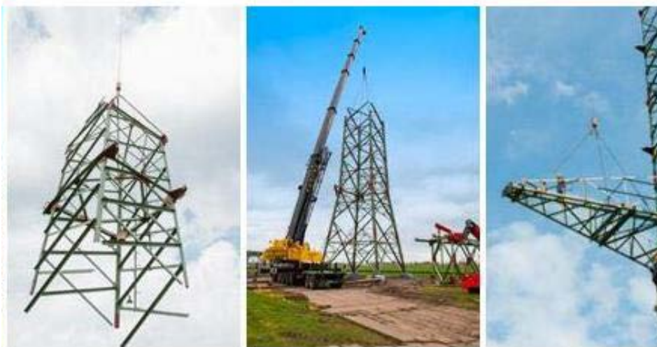
Abbildung 19: Mastmontage mittels Mobilkran
