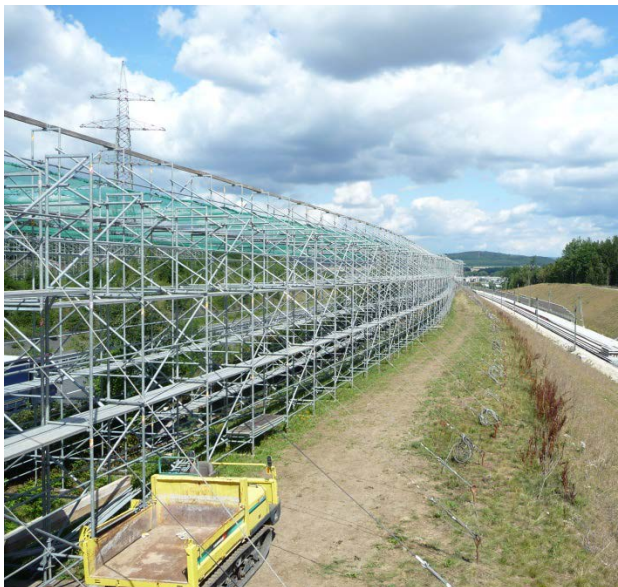
Abbildung 21: Schutzgerüst aus Metall und Schleifgerüst aus Holz
