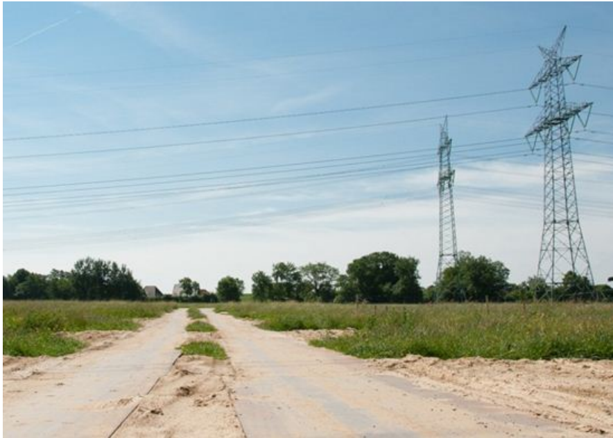
Abbildung 15: Beispiel für eine temporäre Mastzufahrt
