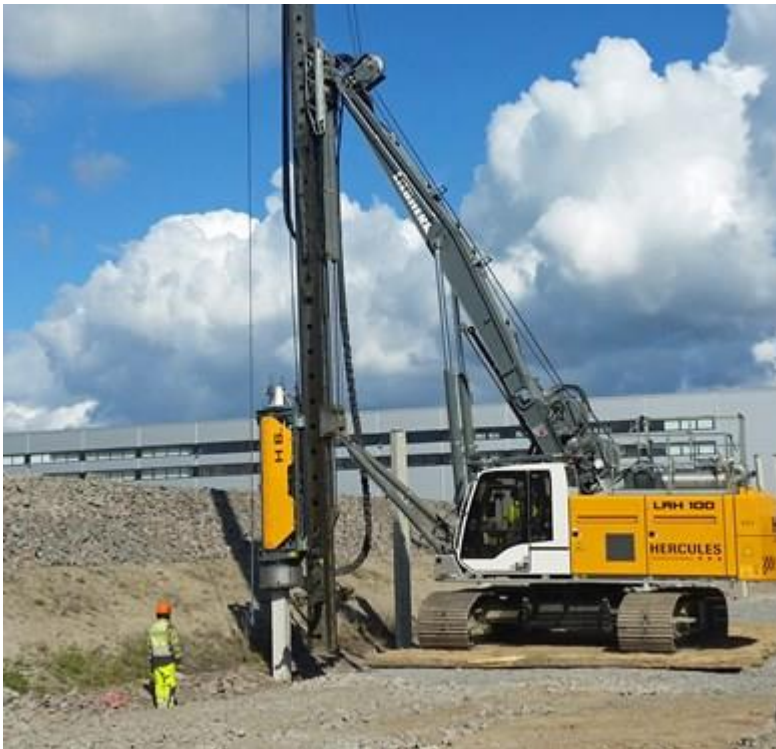
Abbildung 2.3: Rammgerät zur Pfahlgründung der Masten
