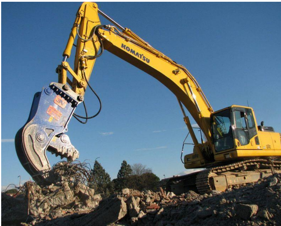
Abbildung 2.2: Bagger mit Abbruchzange (Pulverisierer)
