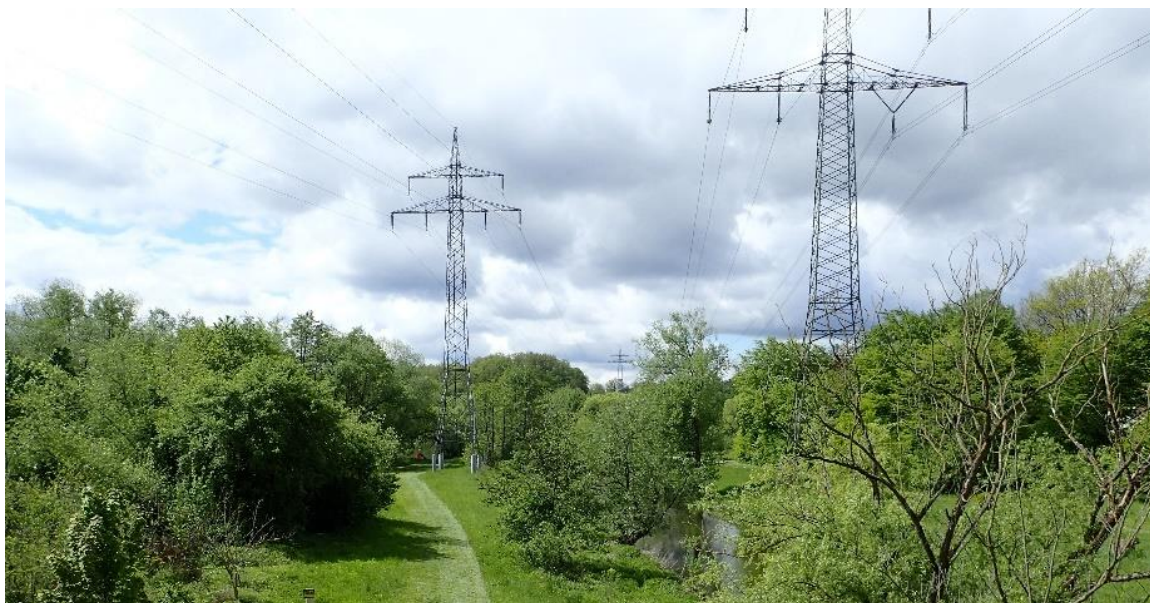
Abbildung 27: Blick von der Naabbrücke bei Etmannsdorf Richtung Südwesten auf die beiden Leitungstrassen: rechts Mast 11 der 380 kV-Bestandsleitung; links Mast 14 der 110-kV-Bestandsleitung
