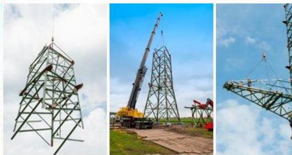
Abbildung 20 Abbildung 48 : Mastmontage mittels Mobilkran
