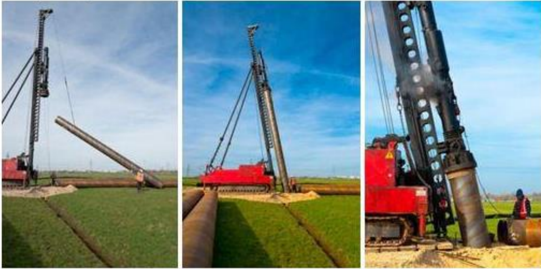
Abbildung 18 Abbildung 46 : Pfahlgründung
