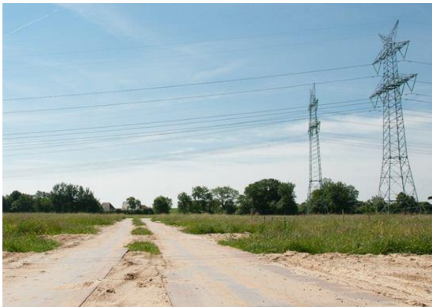
Abbildung 16 Abbildung 44 : Beispiel für eine temporäre Mastzufahrt
