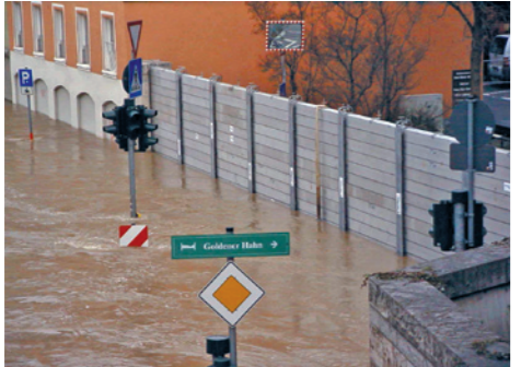
Mobile Hochwasserschutzelemente verhindern die Überflutung der Würzburger Innenstadt, Januar 2003.
