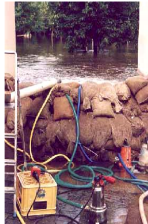
Sandsackbarrieren, Türschotts und Tauchpumpen halten das Hochwasser wirksam fern.
