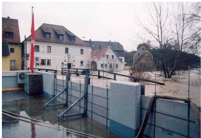
Mobile Türschotts geben Anwesen Schutz (Kallmünz, Januar 2003)
