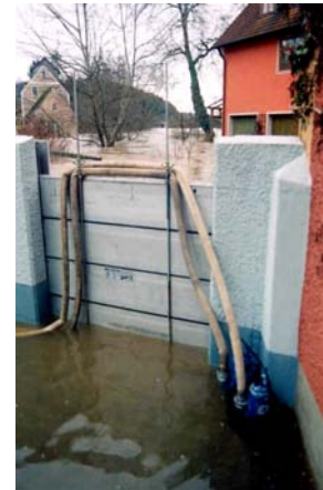
Sandsackbarrieren, Türschotts und Tauchpumpen halten das Hochwasser wirksam fern.
