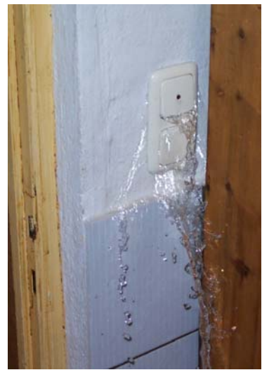
Problemzonen bei Hochwasser: Kelleraußentreppen, undichte Kellerwände, Mauerdurchbrüche.....
