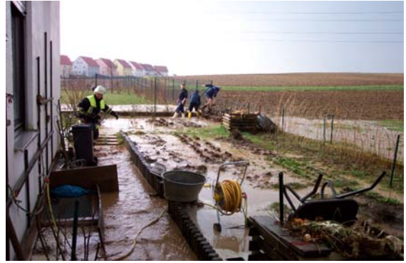
Wild abfließendes Hangwasser dringt über Kellerlichtschächte und Haustüre ein.
