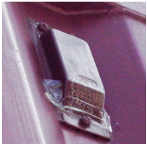
Verklebte Lüftungsschlitze an Containern als Hinweis auf eine Begasung. Die Verklebungen werden nach dem Entgasen oft nicht entfernt.
